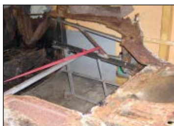
Sur la caisse, la structure du coffre est partiellement refaite.
