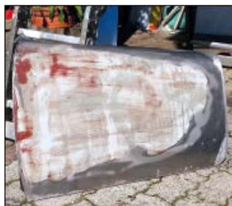
Surprise : c'est plein de mastic !
